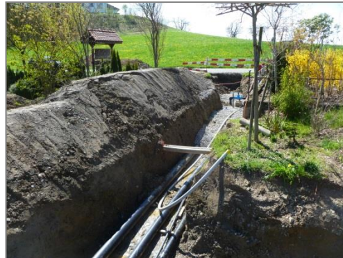
Anschluss- leitungen Reservoir
